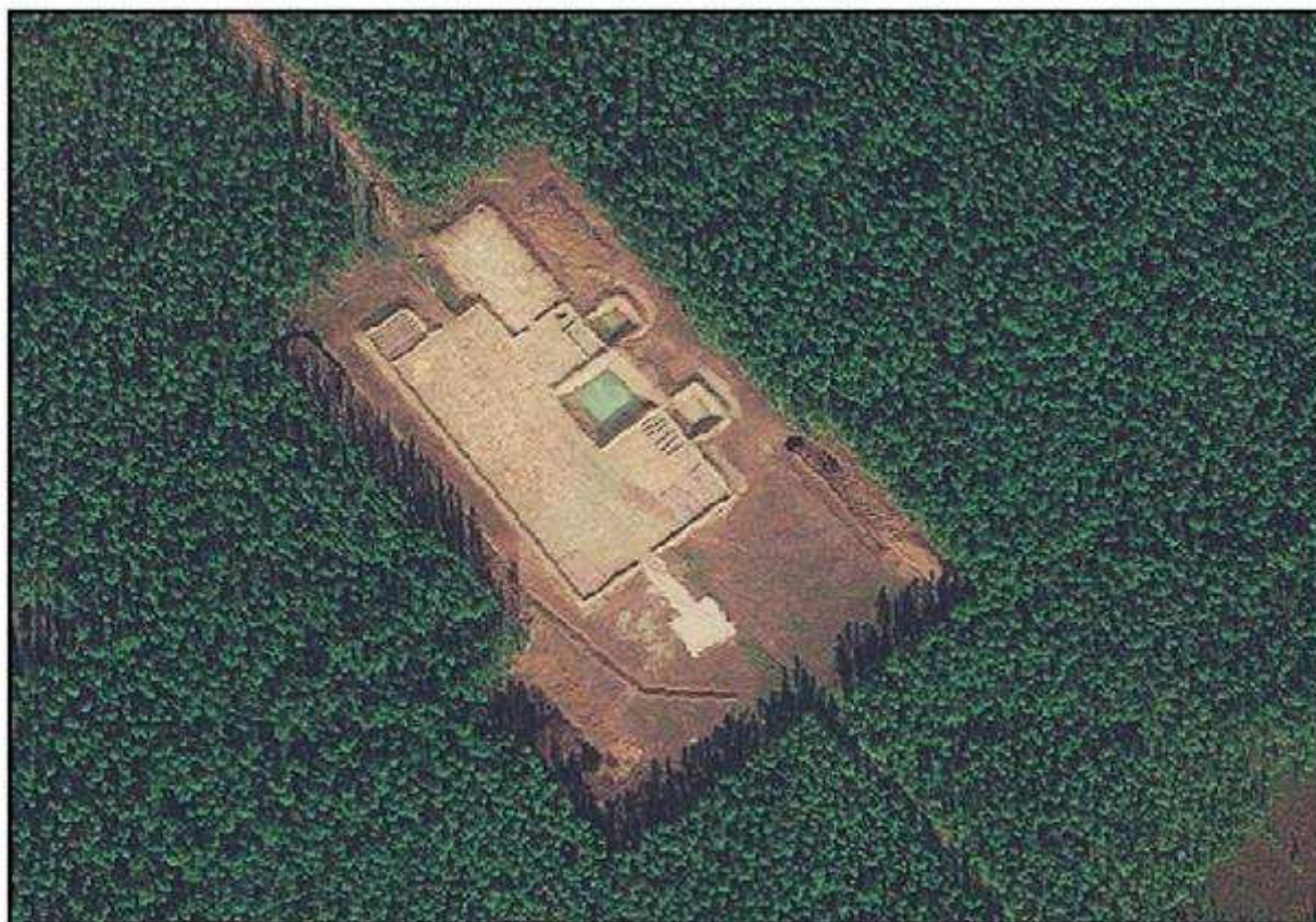
Рисунок 1 – Современная конструкция существующей площадки скважины со ША
